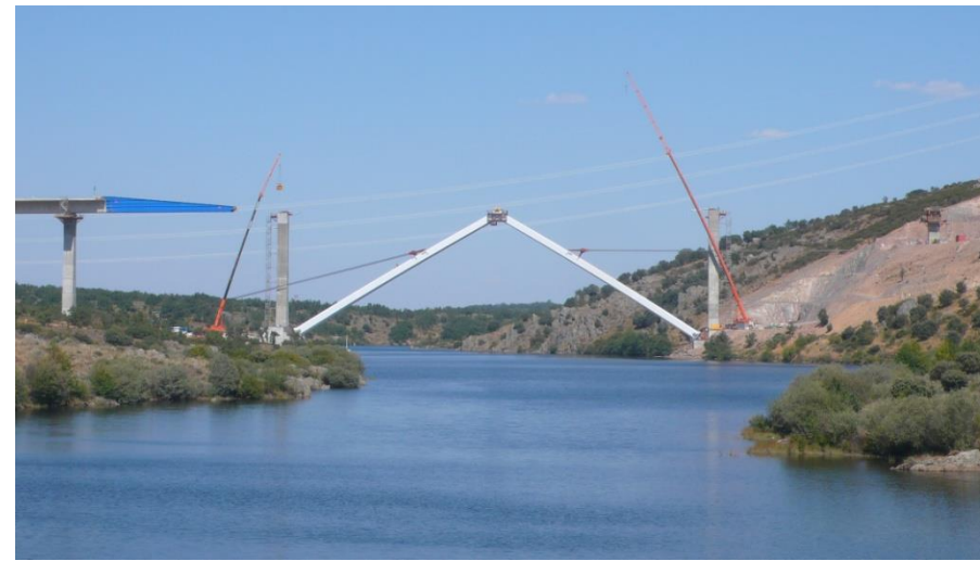
VIADUCTO SOBRE EL RIO TERA EN LA LAV MADRID-GALICIA LONGITUD 645 m LUZ VANOS 75 m LUZ ARCO 150 m
