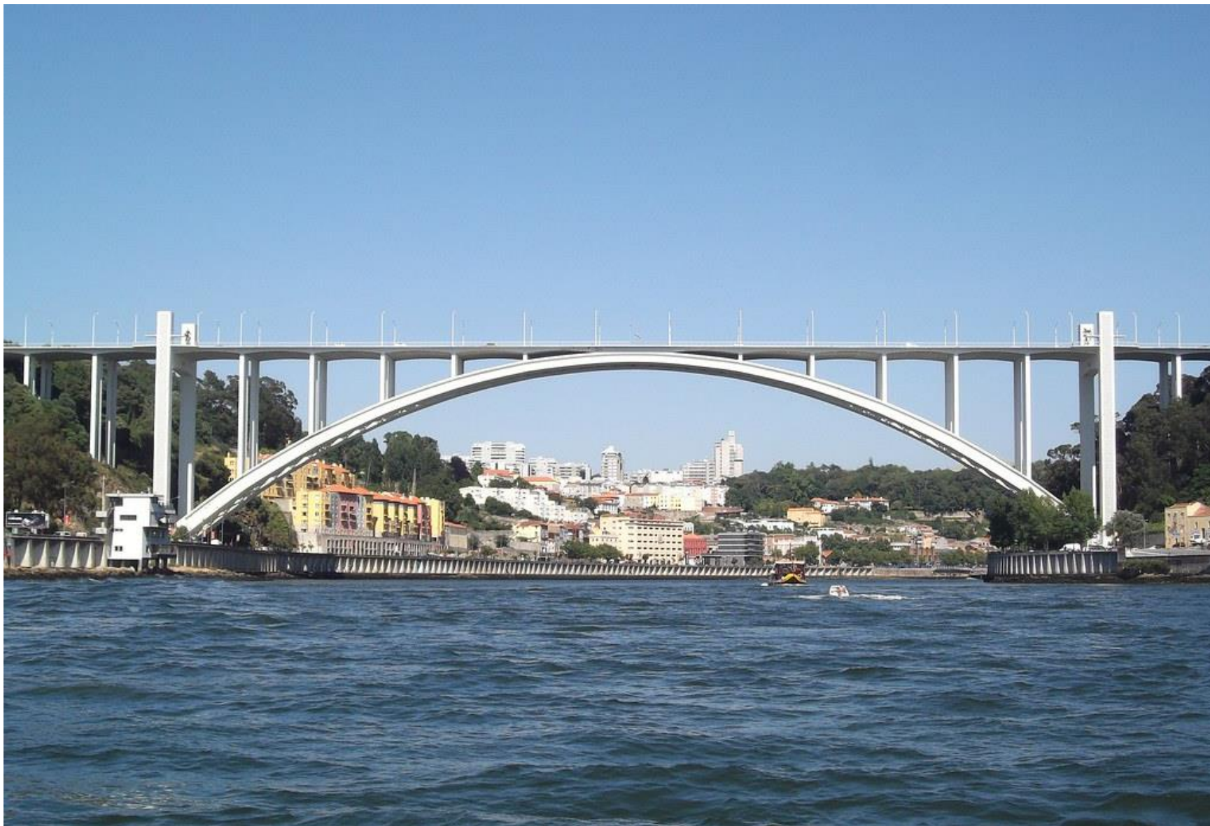
Puente de la Arrabida. Oporto. 1957-1963. Luz 270 m
