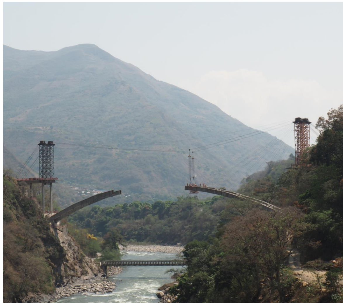
Puente de Maranura. Montaje cimbra
