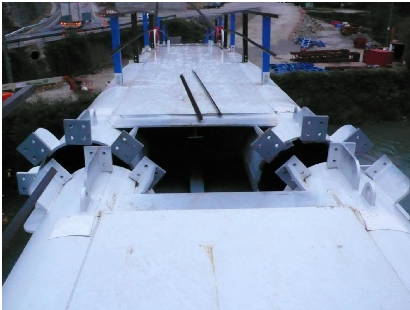
ELEMENTOS PARA EL BLOQUEO PROVISIONAL DE SEMIARCOS EN CLAVE
