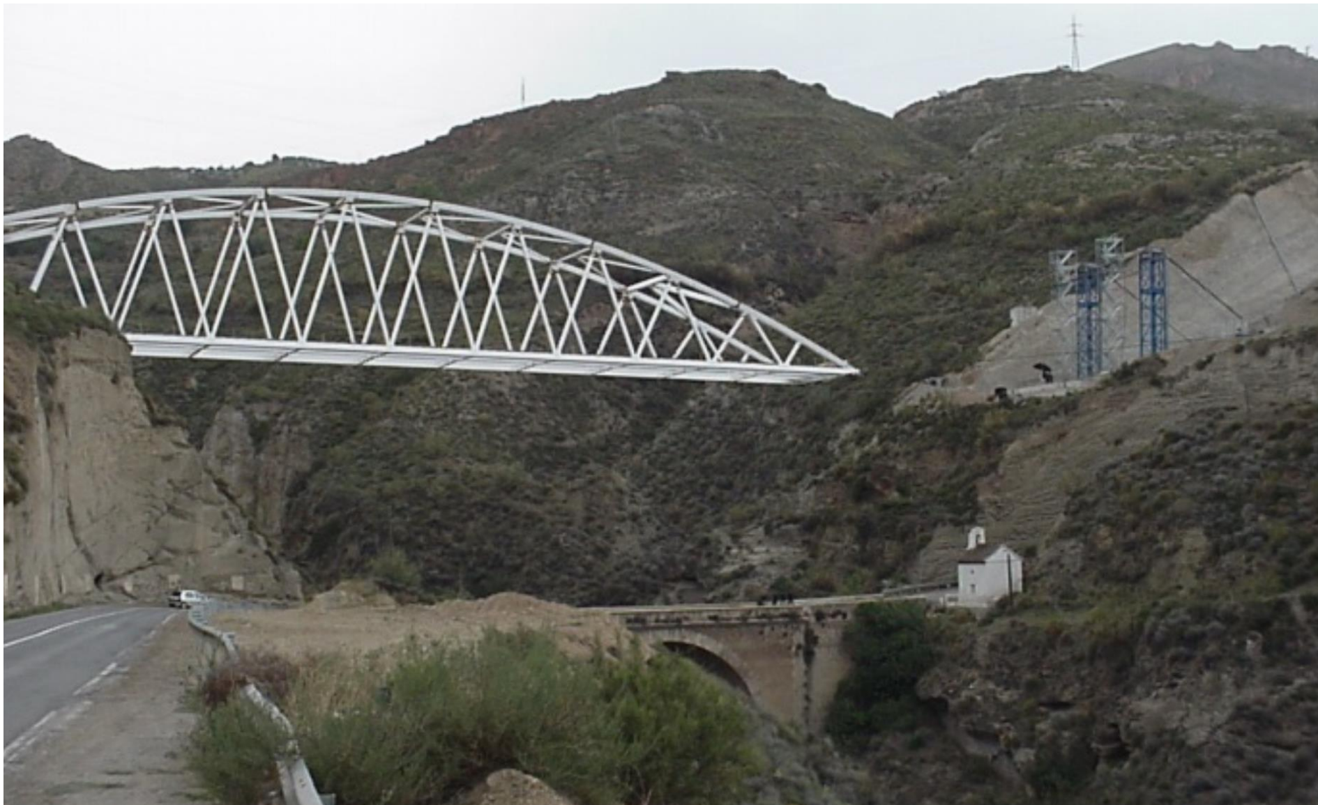
PUENTE DE TABLATE (L = 112 m, 409 ton) TABLATE, ESPAÑA. PROYECTO TORROJA INGENIERÍA
