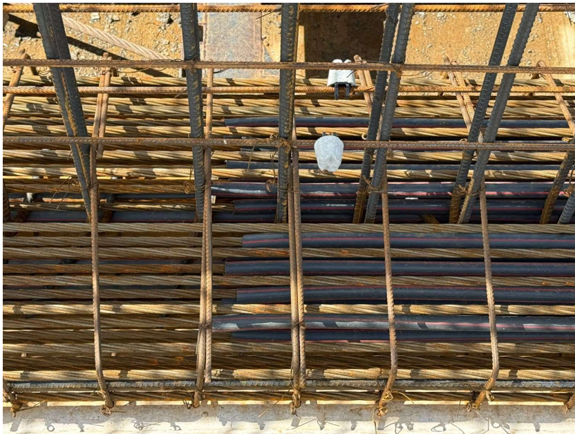
ENCAUCHETADO DE CABLES VIGAS PRETENSADAS
