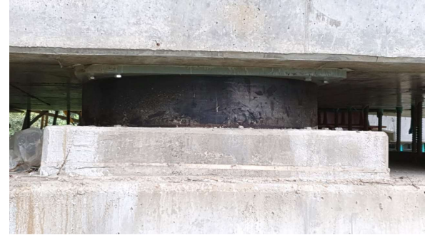
AISLADORES SÍSMICOS DE NÚCLEO DE PLOMO
