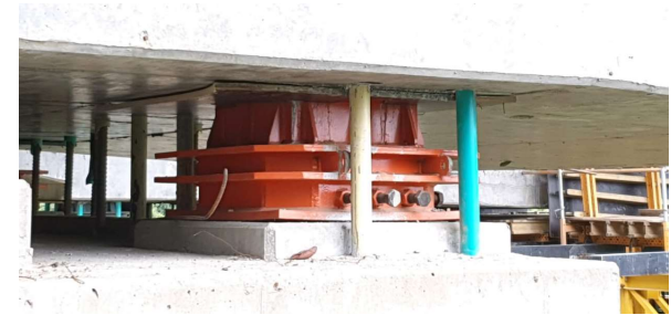
GATOS DE ARENA Y BARRAS DE ALTA RESISTENCIA PARA EL BLOQUEO DEL TABLERO DURANTE CONSTRUCCIÓN
