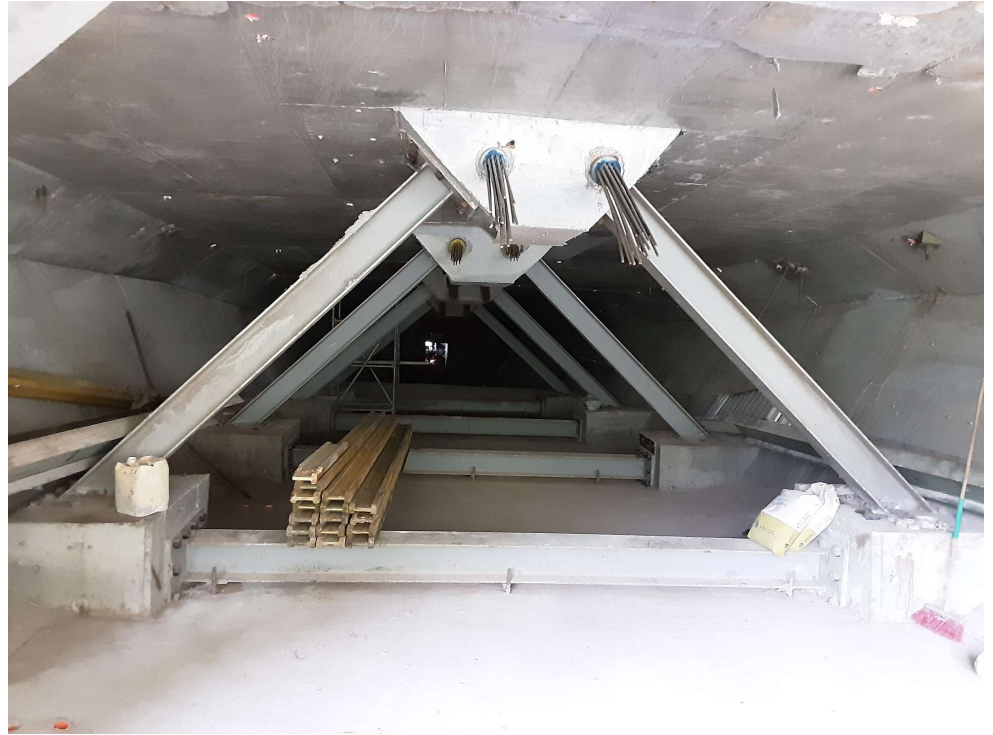
RIOSTRAS INTERNAS PARA ANCLAJE DE LOS TIRANTES
