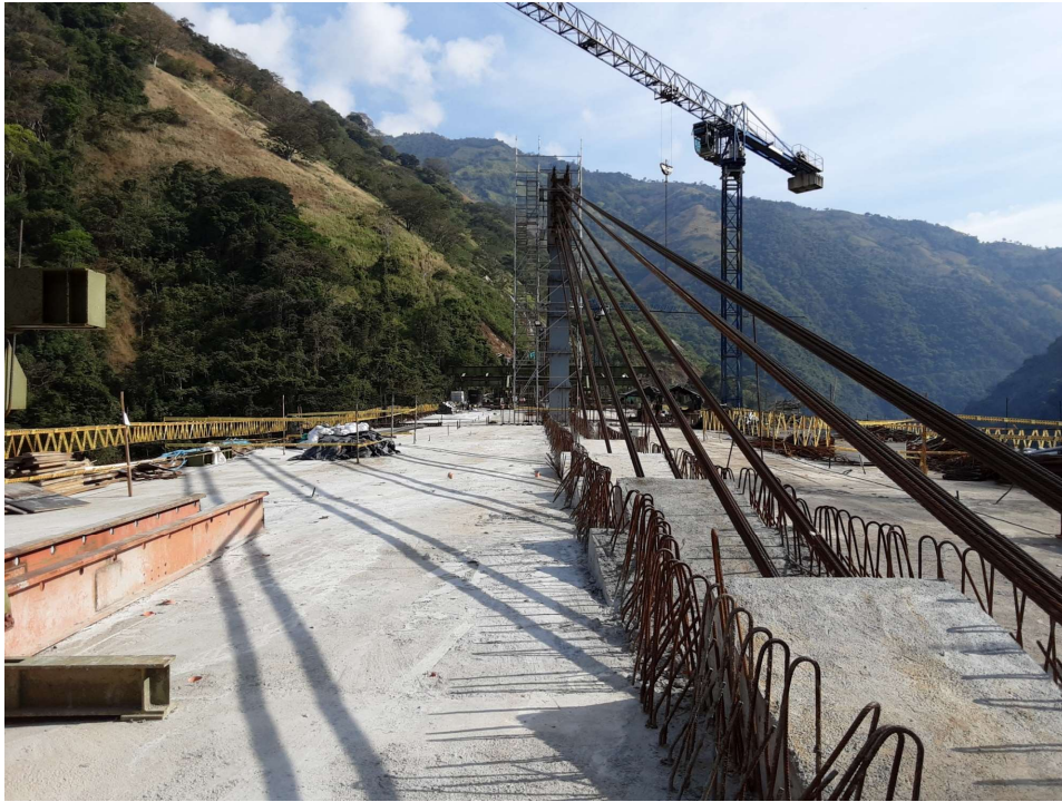
SISTEMA DE ATIRANTAMIENTO TEMPORAL
