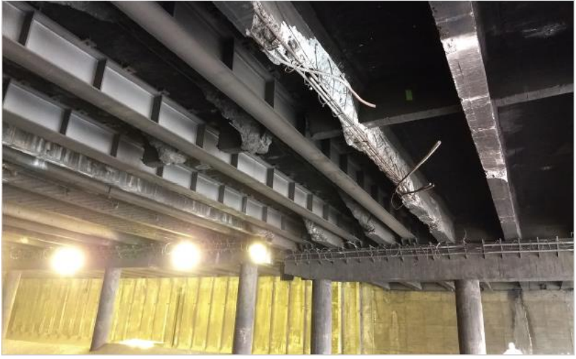
Figura 3.3.6. Impacto lateral en viga de puente por gálibo insuficiente. Foto propiedad Alcaldía de Medellín.
